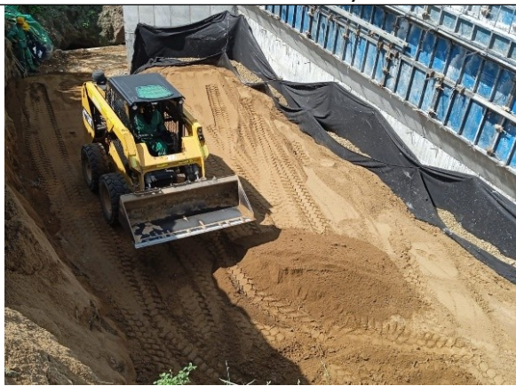
Instalación de filtros y relleno de espaldares con material de terraplén.
