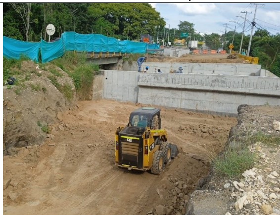
Instalación de filtros y relleno de espaldares con material de terraplén.
