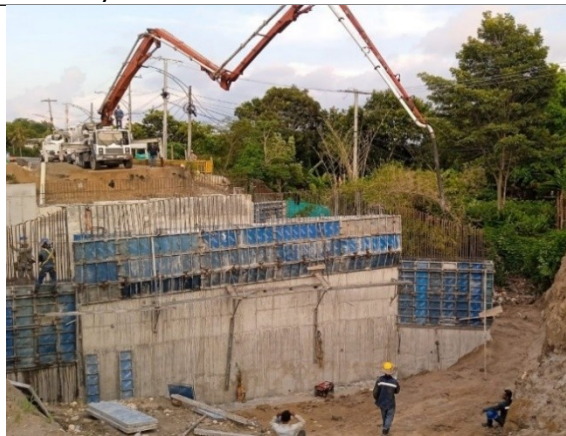
Instalación de filtros y relleno de espaldares con material de terraplén.
