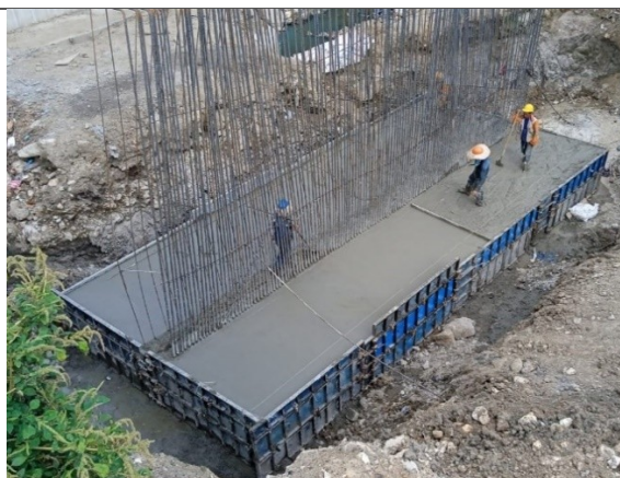
Construcción de estribos y aletas.
