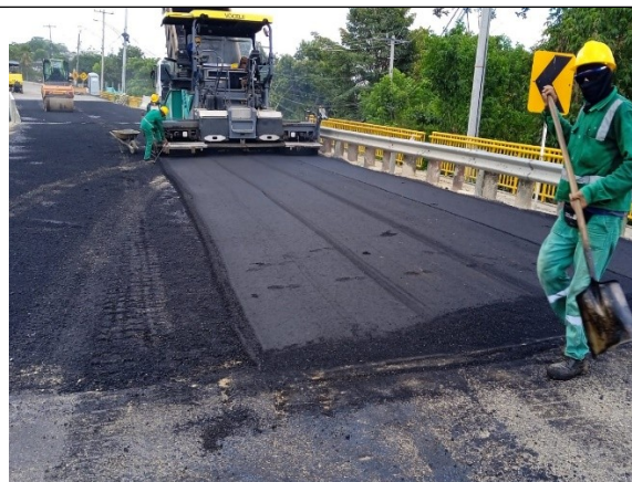
Instalación de asfalto para estructura de pavimento, construcción de New Jersey y señalización.
