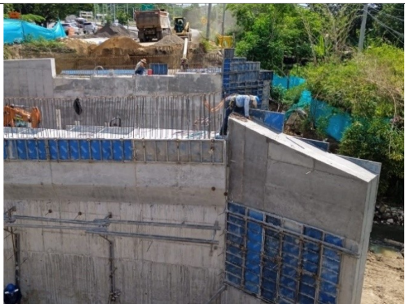
Instalación de filtros y relleno de espaldares con material de terraplén.
