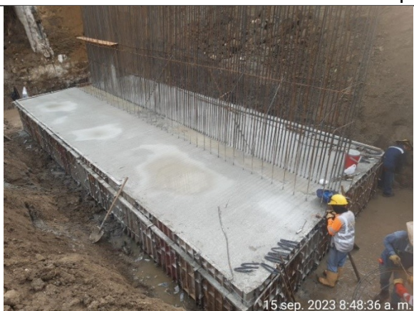
Construcción de estribos y aletas.
