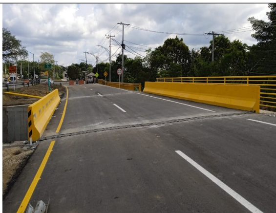
Instalación de asfalto para estructura de pavimento, construcción de New Jersey y señalización.
